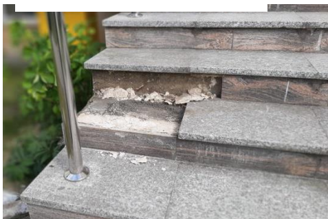
Naprawa uszkodzonych płyt na schodach kościoła i plebani
